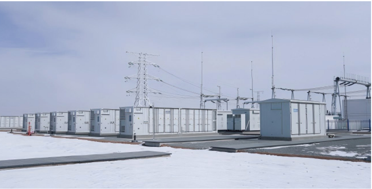
甘肃临泽500MW光伏治沙发电40MW/80MWh储能项目 项目时间: 2022年 项目地点: 甘肃临泽 项目特色: 项目灵活控电, 调节电网拐点, 平抑功率波动
